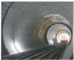
Haupttöhre im Bereich Multifunktionsstelle. © AlpTransit Gotthard AG
