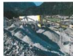
Das von Holcim betriebene Kieswerk in Armutz. © AlpTransit Gotthard AG
