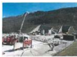
Das künftige Nordportal des Ceneri-Basistunnels. © AlpTransit Gotthard AG
