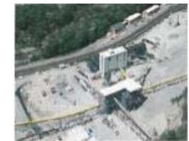
Der Installationsplatz bei Sigirio. © AlpTransit Gotthard AG
