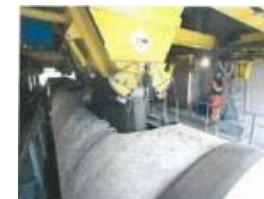
Boden: Beschicken eines Bauszugs mit Beton
