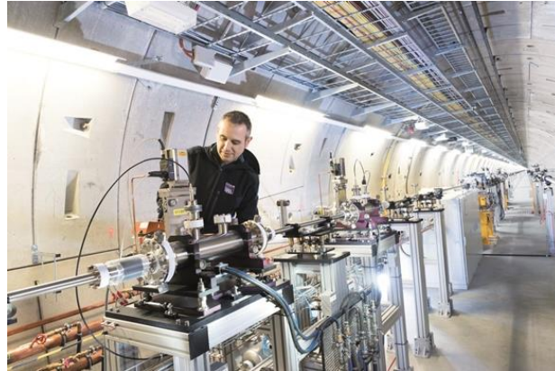
Béton à haute performance produit par LafargeHolcim pour les tunnels du laser European XFEL (Photo: European XFEL)
