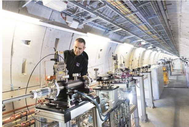
Spezieller Hochleistungsbeton von LafargeHolcim für die Tunnel des European XFEL (Bild: European XFEL)
