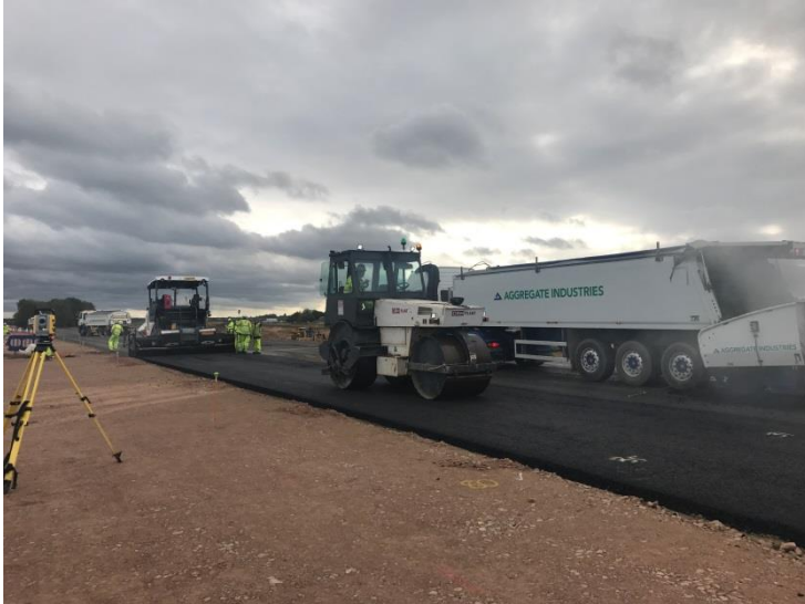
Photo: Travaux sur l'autoroute A14
