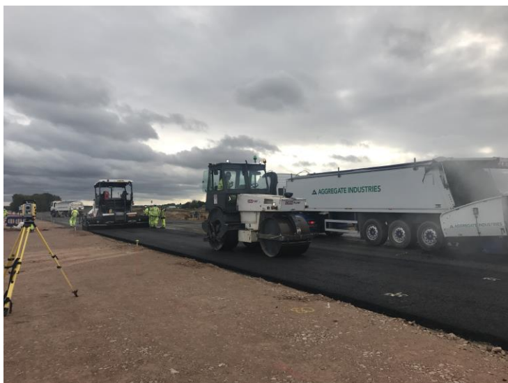
Foto: Bauarbeiten an der Autobahn A14
